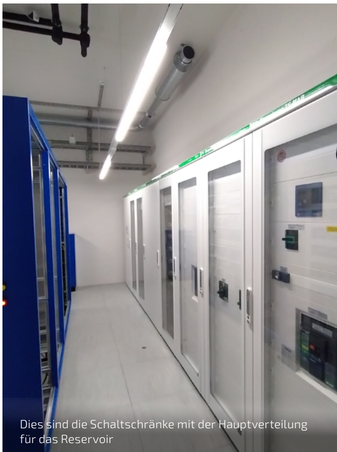
Für die saubere und platzsparende Kabelführung wurde unter den Schränken ein Doppelboden montiert
