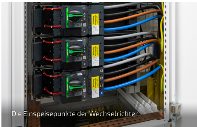
Der durch die PV-Anlage erzeugte Strom wird durch die Wechselrichter (links) ins Netz eingespeist
