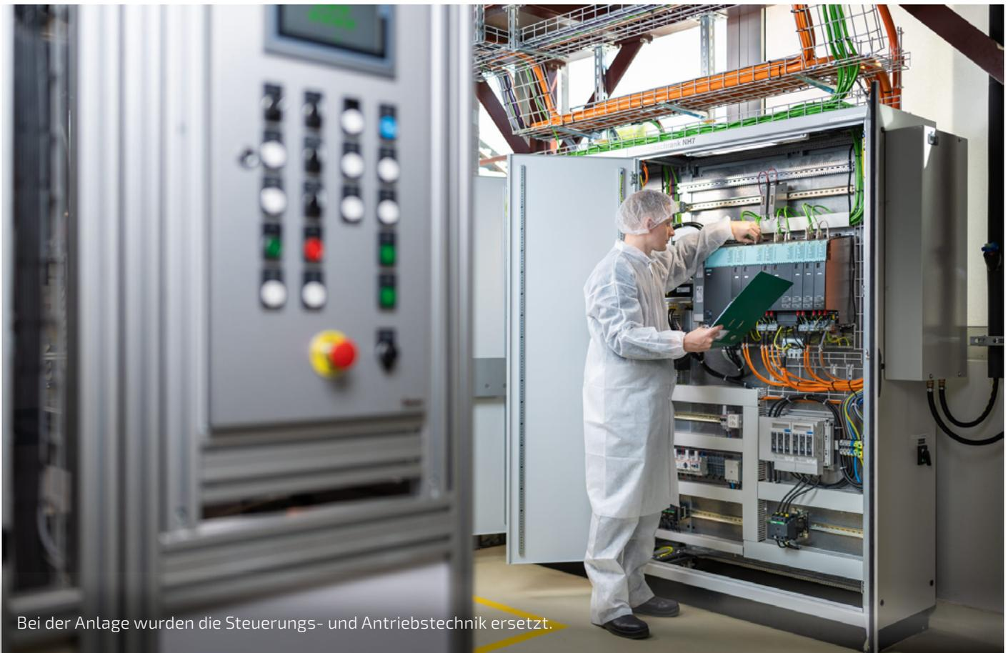
Bei der Anlage wurden die Steuerungs- und Antriebstechnik ersetzt.
