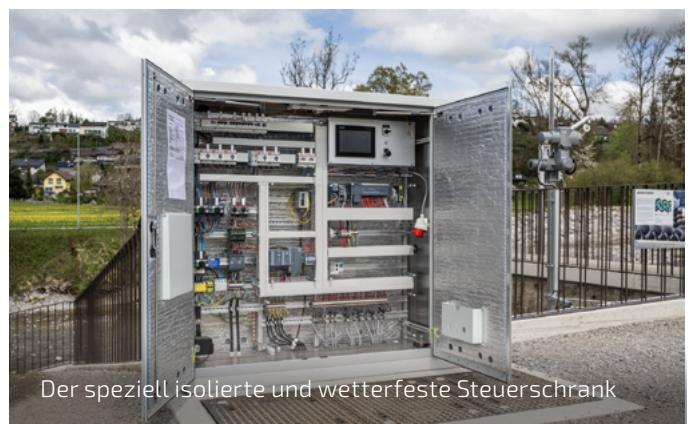
Der speziell isolierte und witterfeste Steuerschrank
