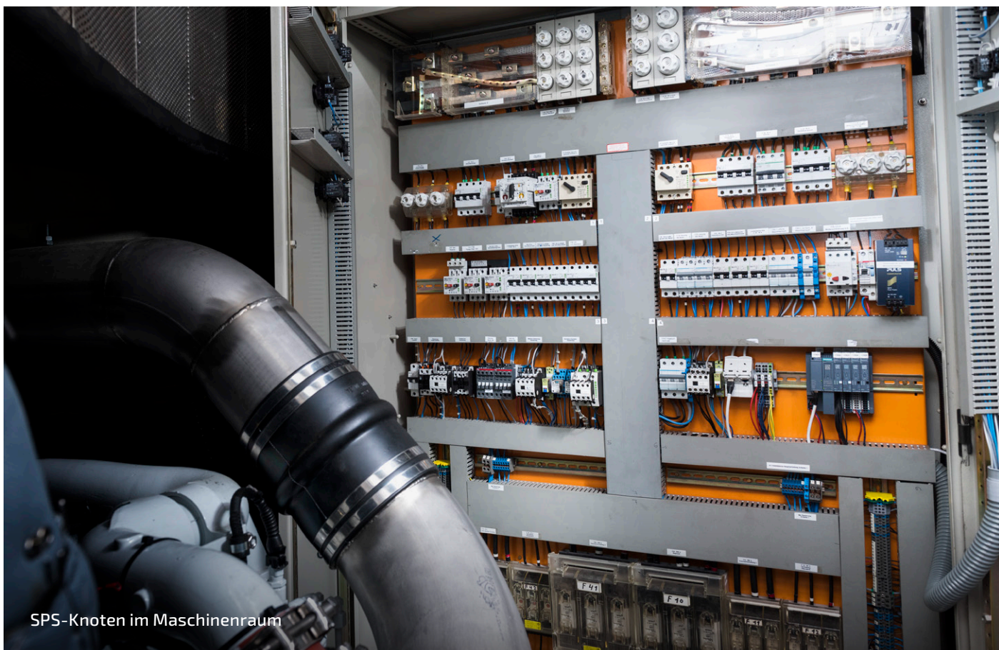
SPS-Knoten im Steuerhaus
