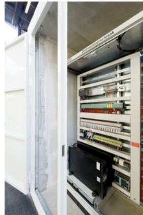
Zentralsteuerschrank
