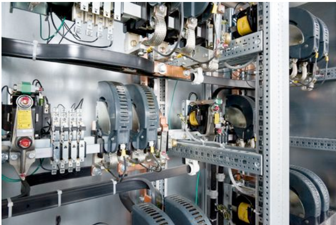
Barrenschütze für Abgänge 600VDC mit automatischer Erdung
